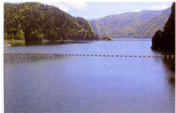
写真-2 ダム堤頂から上流側の眺望
