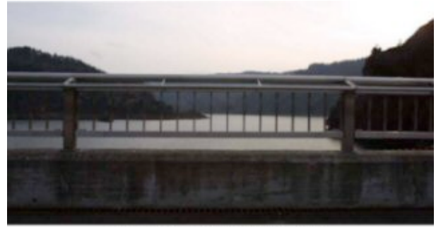
写真－10 上流の展望：新し手摺り
